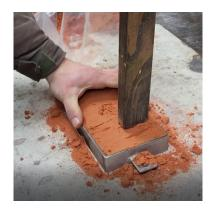
6. Den Prozess des Aufstreuens und Verdichtens wiederholen Sie so lange, bis der Formkasten noch überquillt, nachdem Sie verdichtet haben.
